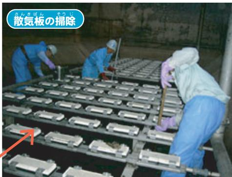
生物反応槽の中で散気板を掃除しています。また、生物反応槽にたまった砂などのゴミを取り除いています。
